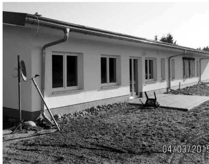
Neubau eines Wirtschaftsgebäudes mit integrierter Ferienwohnung. Foto: Kraushaar
