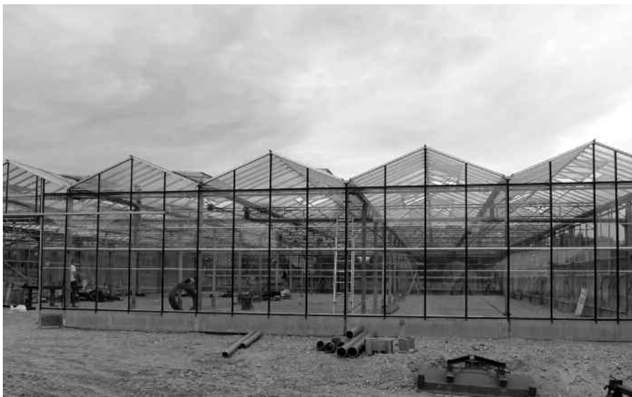
Gefördertes Projekt: Gewächshausneubau.
