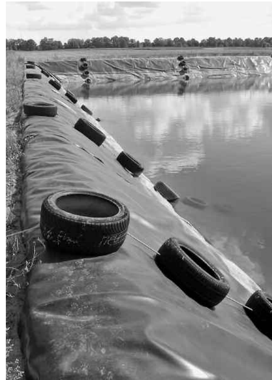
Gefördertes Projekt: Speicherbecken im Obstgut Müller in Wesendahl. Foto: Reise
