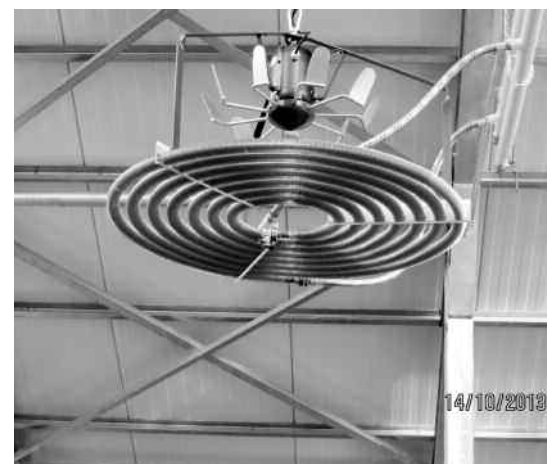
Modernisierung eines Heizungssystems. Foto: Kraushaar
